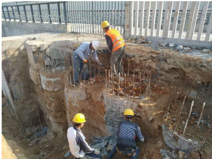
图4 建筑工程深基坑护坡桩施工图
